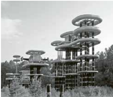
Высоковольтные трансформаторы в г. Истра Московской обл.
